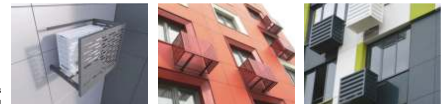
Примеры маскирующих экранов систем кондиционирования
